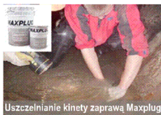
Uszczelnianie kinyty zaprawą Maxplug
